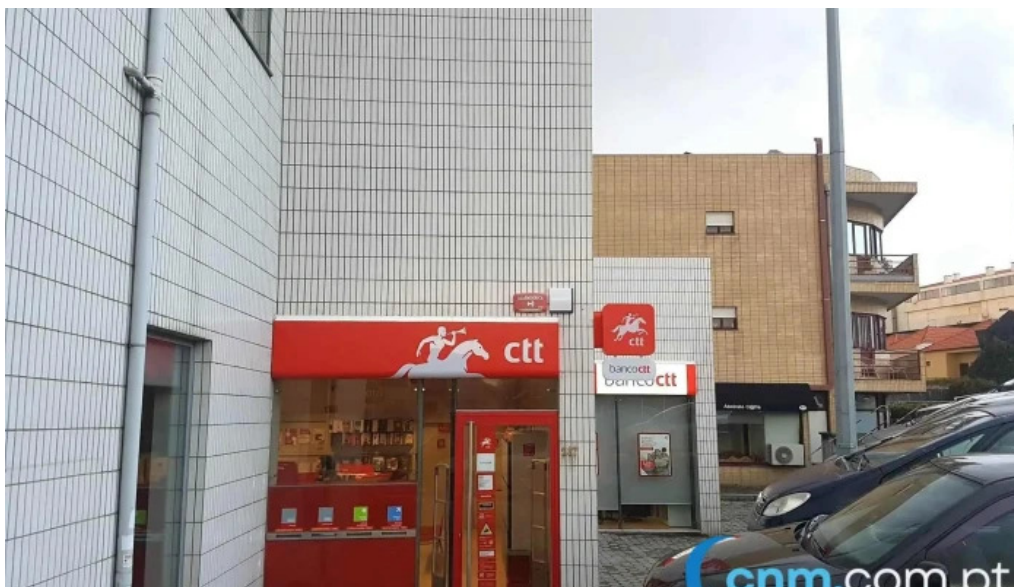
Posto de correios de valadares exterior
